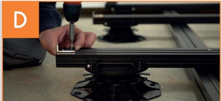
Terrassenlager mit Schienen verschrauben und Wand-Fix setzen
