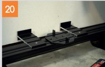
Nun können jeweils links und rechts neben dem M-Fix, in einem Abstand von ca. 2 cm, die S-Fixe gesetzt und mit der Bohrschraube 3,9x16 mm verschraubt werden.
