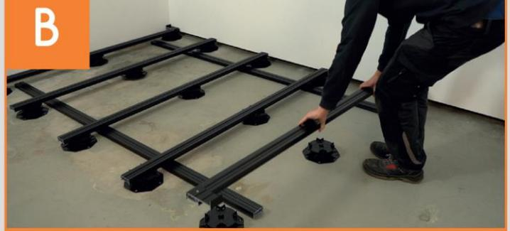
Schiene auflipsen und Abstände auf Plattenbreite ausrichten
