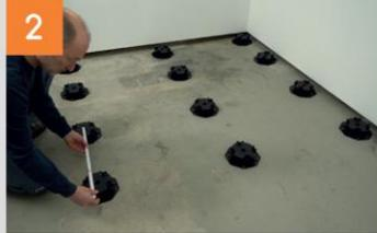
Beim Aufstellen der ersten Terrassenlager richten sich die Abstände der Lager unter den Schienen nach der statischen Belastbarkeit der Schiene (A) und die Abstände in der Breite nach der Plattenbreite (B). Wichtig: Der Abstand (C) der Lager unter der ersten und letzten Plattenreihe ist um 91,4 mm geringer als zwischen den mittleren Reihen (B). Maßübersicht Seite 4.
