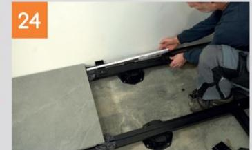
Verschrauben der M-Fixe mit der Bohrschraube 3,9x16 mm. Die nächsten Platten werden dann nach dem beschriebenen Prinzip eingelegt.
