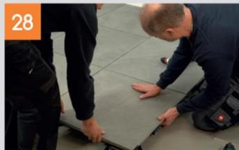
Die letzte Reihe der Fläche sollte nach dem gleichen Schema verlegt werden wie die erste: Die M-Fixe platzieren dann die S-Fixe 2 cm links und rechts daneben verschrauben. Dann können die letzten Platten eingelegt werden.
