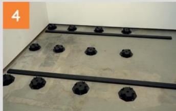
Bevor die Schienen auf die Terrassenlager geclipst werden, wird die Konterlattung, die zur Stabilisierung der Konstruktion dient, ausgelegt. Je nach Bausituation sollte der Abstand max. 300 cm betragen. In jedem Fall müssen mind. 2 Profile gesetzt werden.
