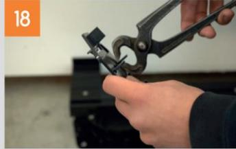
Dann werden die M-Fixe auf der 1. Schiene dem Plattenmaß entsprechend vermessen und aufgesetzt (noch nicht verschraubt). Mit Hilfe einer Kneifzange werden zuvor die nicht benötigten Abstandsstege entfernt.
