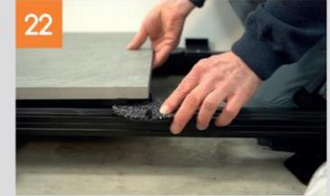
Nach Auflegen wird die erste Platte an dem Wand-Fix und an dem S-Fix ausgerichtet und eingelegt. Der M-Fix wird so nachgeführt, dass er fest an der Platte anliegt.
