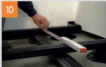
Nun muss die Konstruktion in Längs- und Querrichtung in der Höhe ausgerichtet werden.
