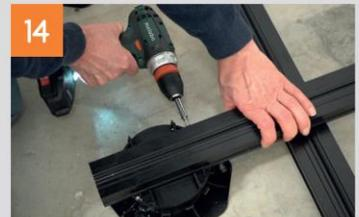
Nun werden die Terrassenlager mit der Alu-UK verschraubt. Dazu mit einem 3 mm Metallbohrer vorbohren und die Lager an der Innen- und Außenseite mit der Alu-UK (Bohrschraube 3,9x19 mm) verschrauben.
