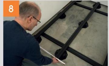
Die folgenden Schienen werden auf die bereits grob ausgerichteten Terrassenlager aufgeclipst. Dabei sollten die Maße von Schiene zu Schiene entsprechend der Plattenbreite kontrolliert werden. Maßübersicht Seite 4.
